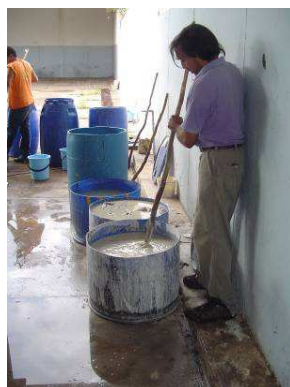
Figura 4 – Removiendo lechada de cal para un encalado más uniforme
